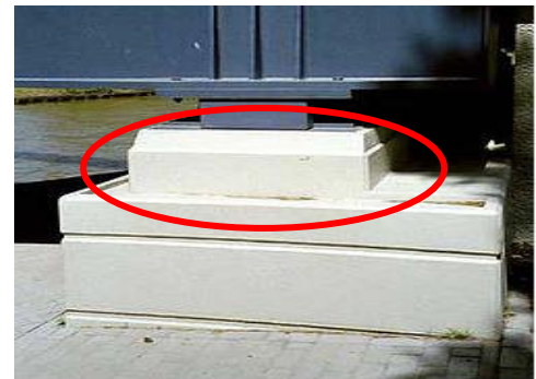
Figure A.I.3. Dés d'appui
