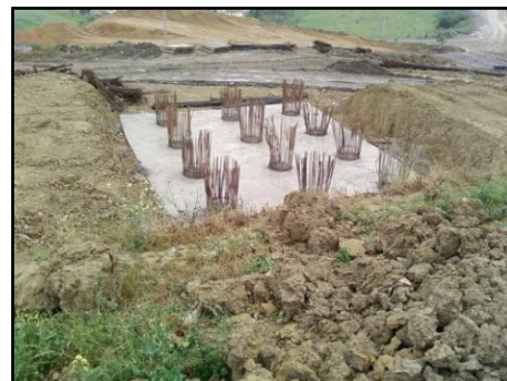
Figure C.4. Vue des pieux sur site
