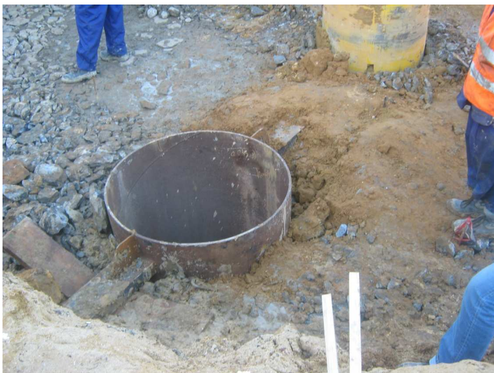
Fig.3 : Installation du tubage provisoire.
