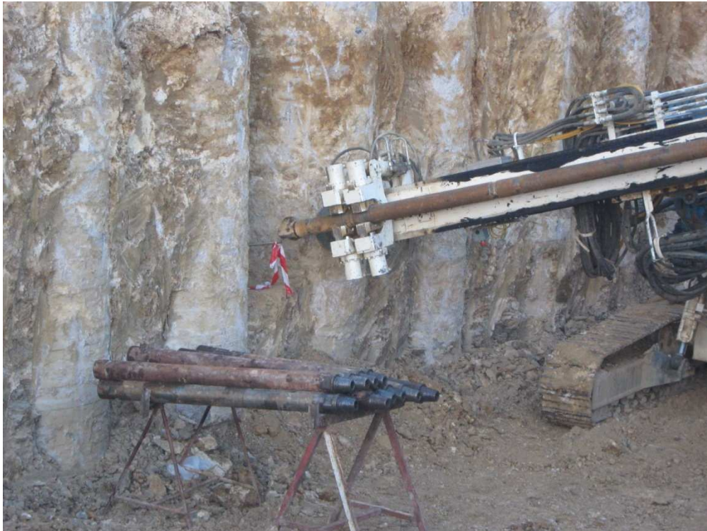
Fig.6 : Traçage des tirants d'ancrage.
