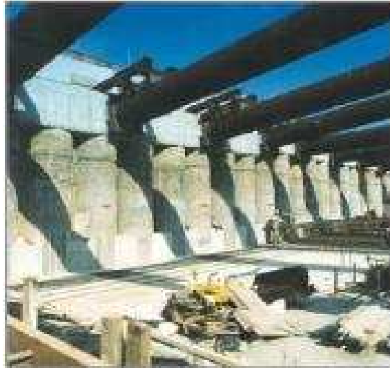
Fig.III.4 : Pieux sécants
