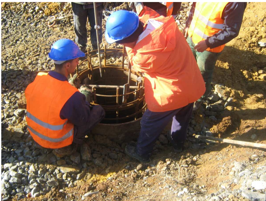
Fig.4 : Mise en place de la cage d'armature.
