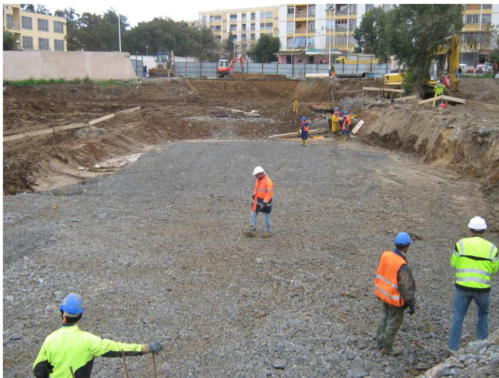
Fig.2 : Réalisation de la plate-forme de travail
