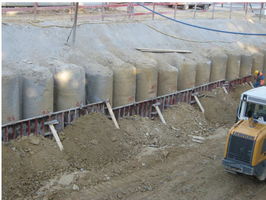
Fig.5 : le soutènement avec des pieux forés.
