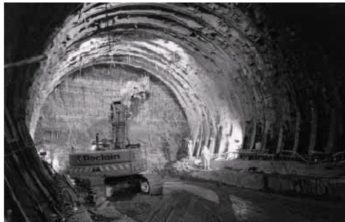
Figure II.1 : Méthode à pleine section
