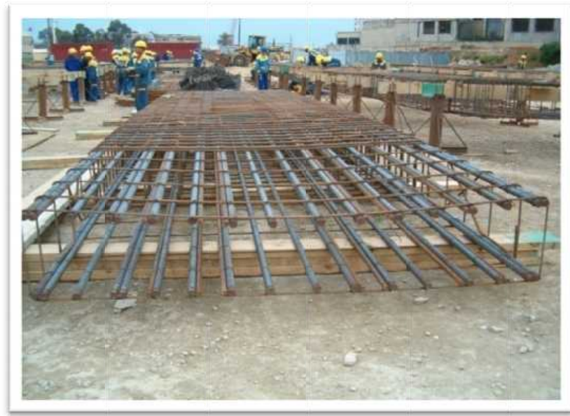
Figure III. 6 : Cage d'armature façonner sur place (photo reproduite avec la permission de Metro d'Alger)
