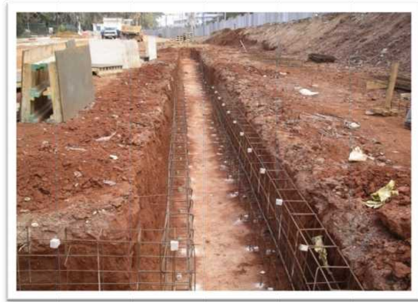
Figure III. 7 : Tranchée guide (photo reproduite avec la permission de Metro d'Alger)
