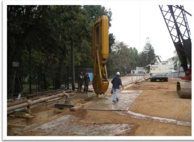
Figure III. 1 : Benne preneuse (photo reproduite avec la permission de Metro d'Alger)
