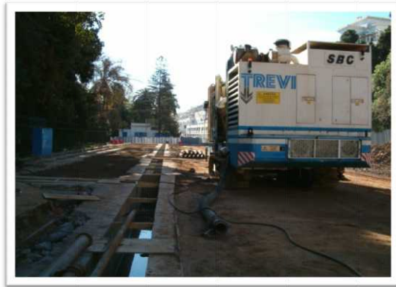
Figure III. 5 : Bétonnage (photo reproduite avec la permission de Metro d'Alger)
