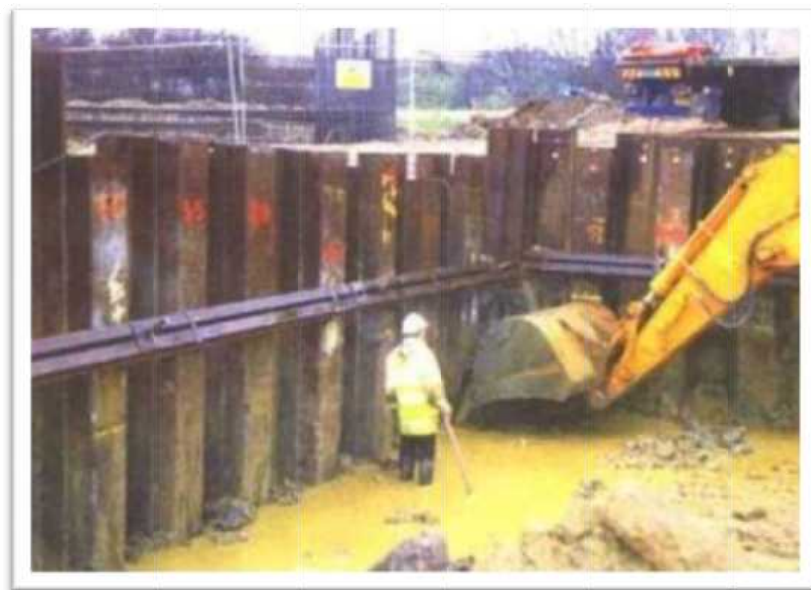
Figure III. 2 : Excavation avec l'utilisation des tirants
