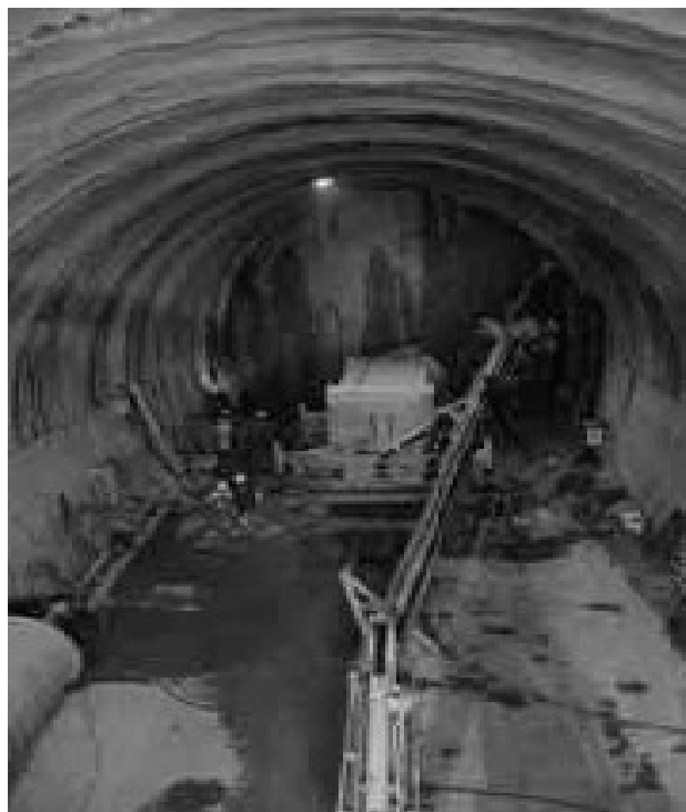
Figure -1 Renforcement du front de taille par boulonnage
