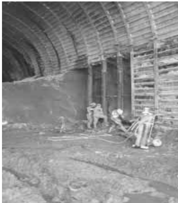
Figure4-11 Soutènement par blindage
