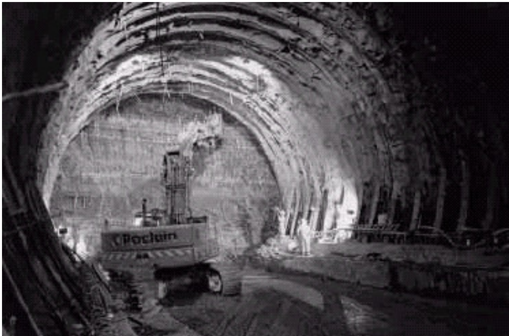
Figure 3-1 Creusement en pleine section
