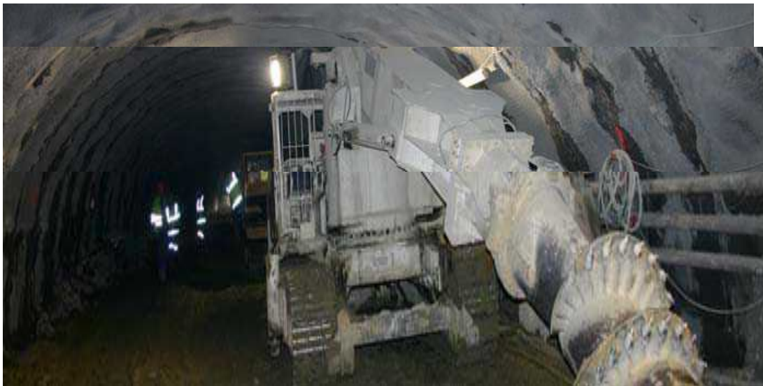
Figure3-5 Machine à attaque ponctuelle
