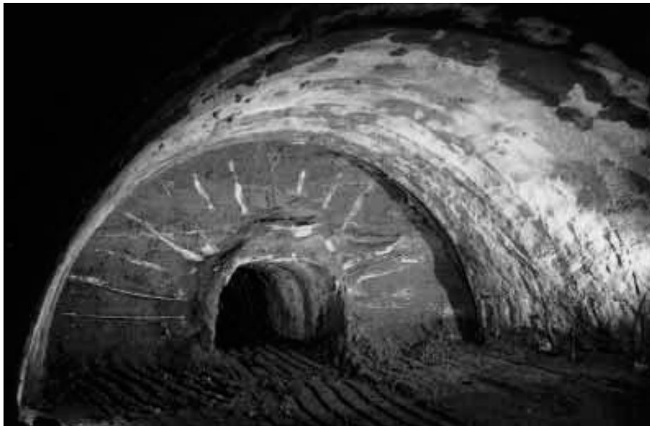
Figure 2-1 Exemple de galerie de reconnaissance
