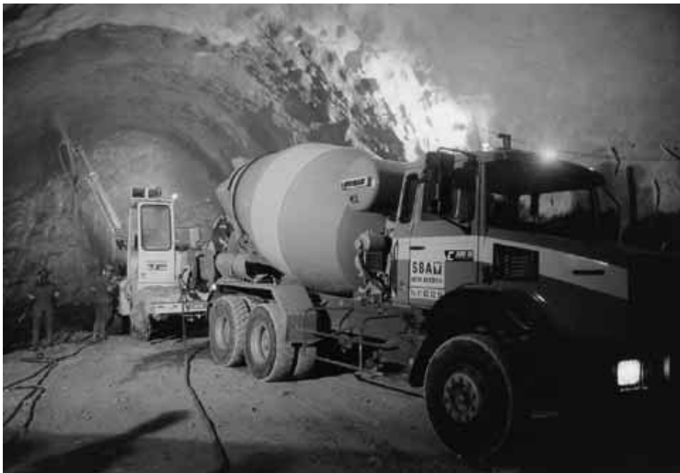
Figure4-12 Béton projeté
