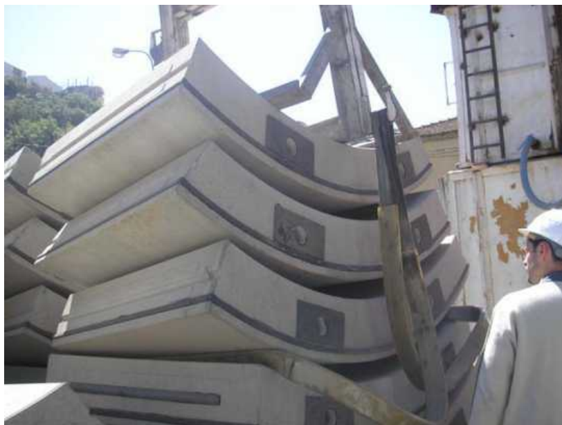
Figure4-13 Voussoirs en béton
