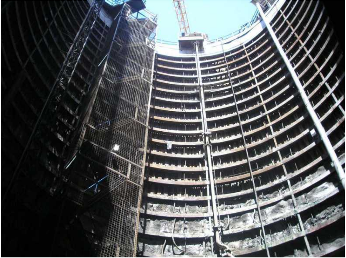
Figure 4-14 Soutènement d'un puit
