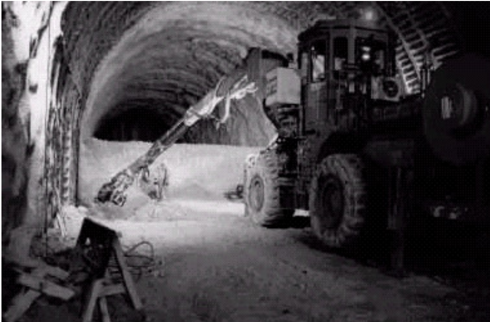
Figure 3-2 Creusement en demi-section
