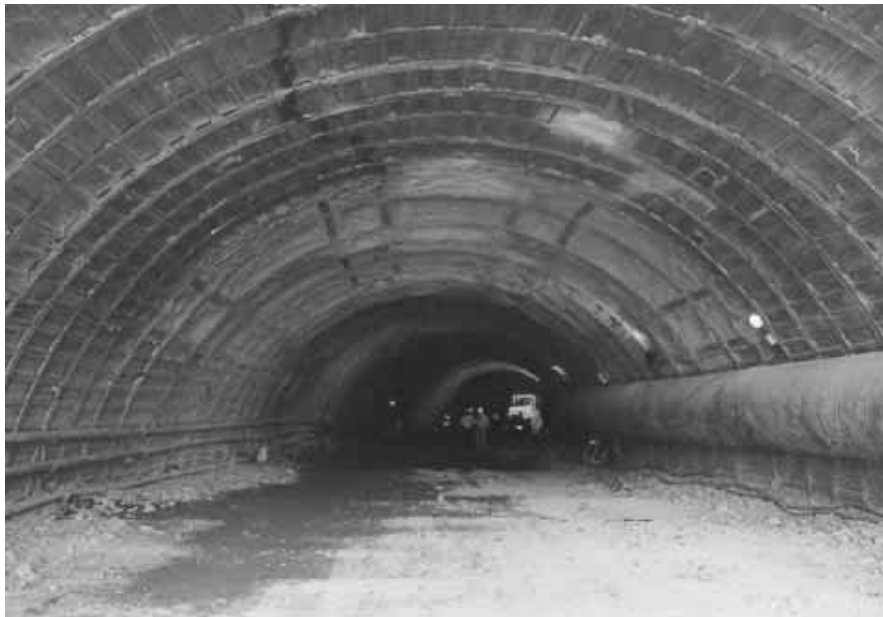
Figure 4-7 Profil de soutènement avec cintres lourds
