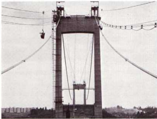
Fig. III.1. Lancement des câbles porteurs
