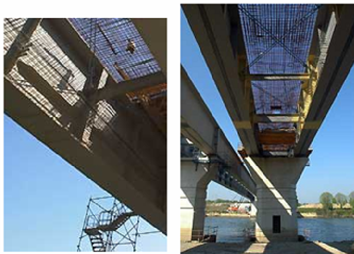
Fig.I.9 : La pose des armatures en place
