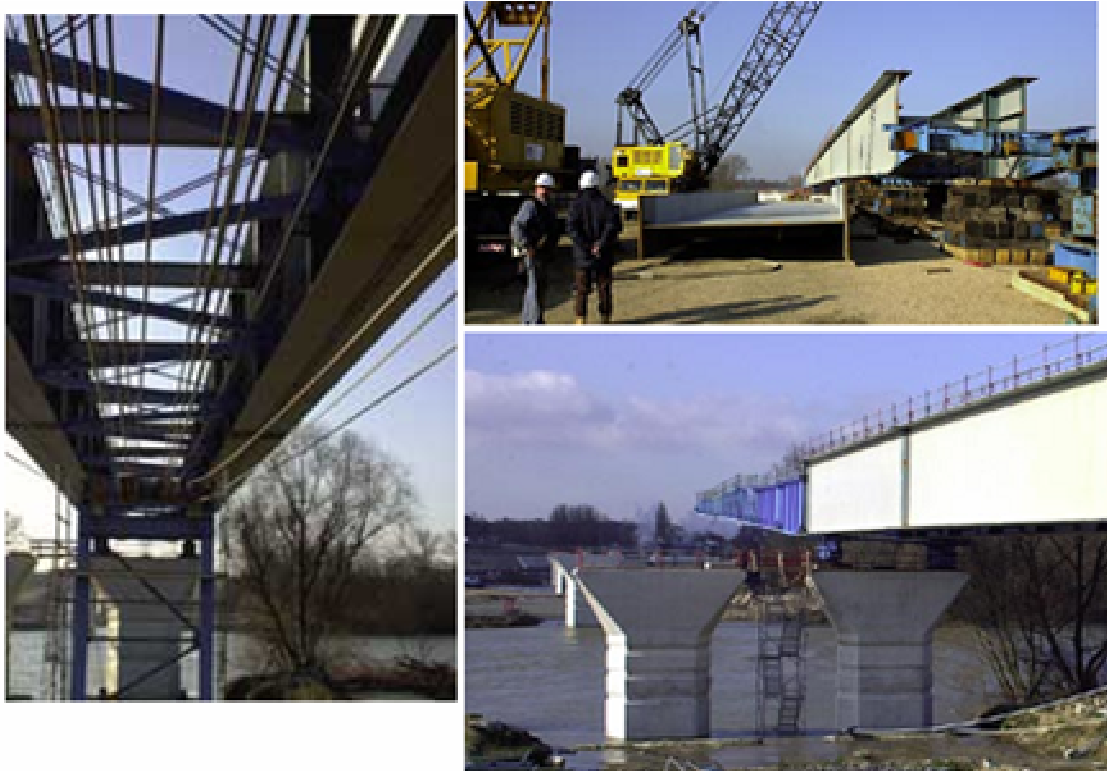
Fig.I.8 : l'opération de lançage
