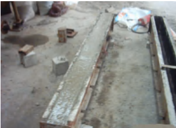
Figure P4 : Coulage des poutres
