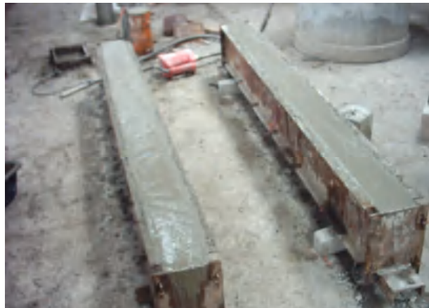
Figure P4 : Coulage des poutres
