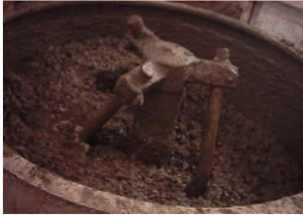
Figure P3 : Malaxage du béton
