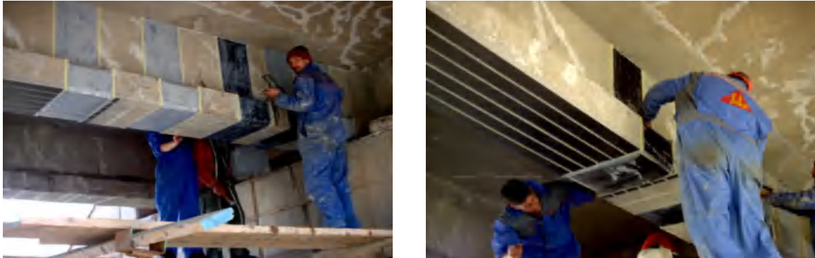
Figure 1.1b : Pose du tissu SIKAWRAP
