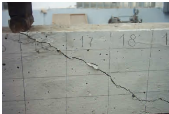
Figure 3.13b : Fissuration de la poutre 2 à la rupture
