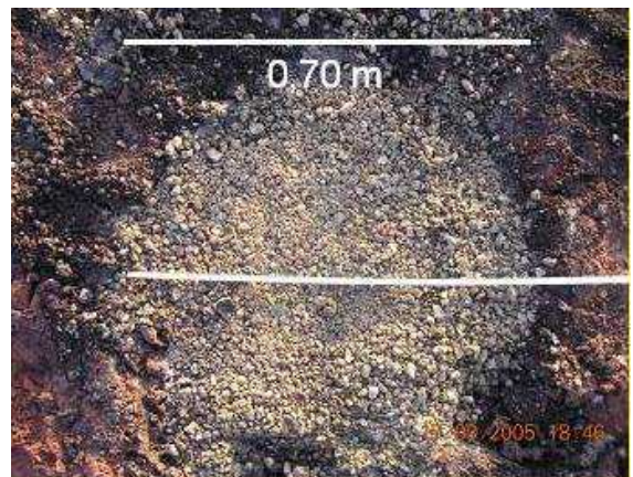
Figure 7-6 Coupe d'une colonne ballastée
