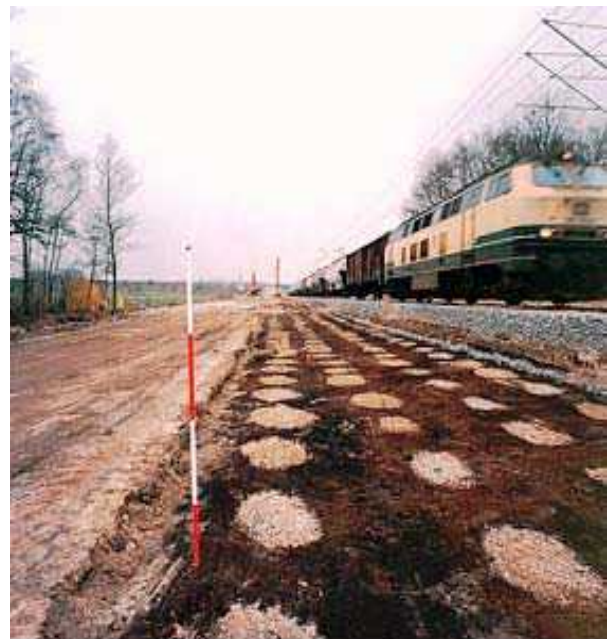
Figure 7-8 Fond de fouille après réalisation des colonnes ballastées
