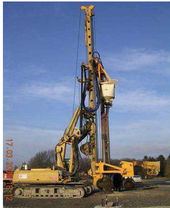
Figure 7-10 Grue portant le vibreur à sas
