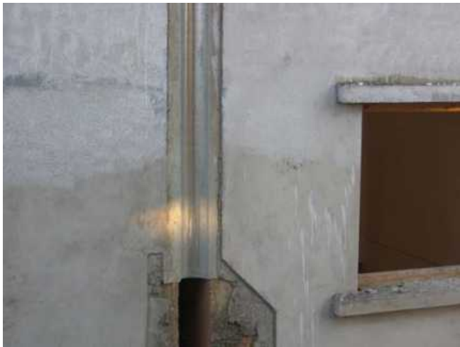
Figure 5.29 d). Joint sismique masqué.
