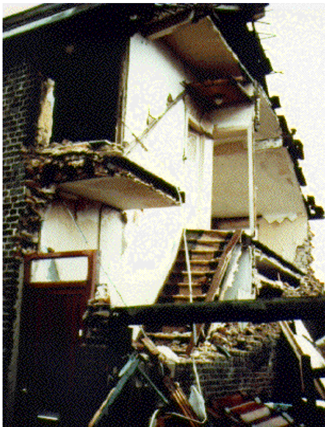
Figure 5.16. Effet d'un séisme sur une construction en maçonnerie sans (à g.) et avec (à dr.).
